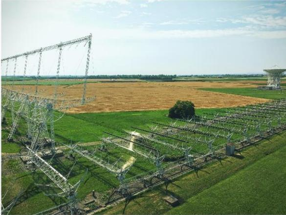
È costituita da due rami perpendicolari: Est-Ovest 564m e Nord-Sud 640m, possedendo quindi un'area di raccolta di 27000 m<sup>2</sup>. La frequenza a cui lavora è quella di 408 MHz, ovvero quella di radiazione del carbonio.
