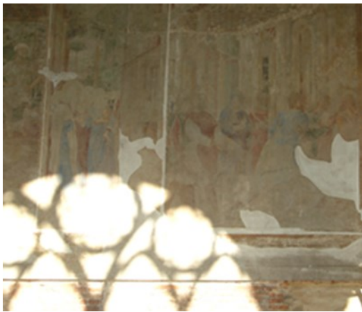
Parete illuminata da radiazione solare diretta
