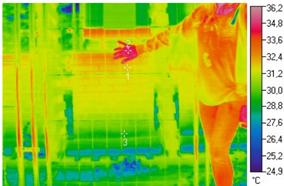
Esempio di termografia su muratura, le differenze termiche sono evidenziate dalla scala.
